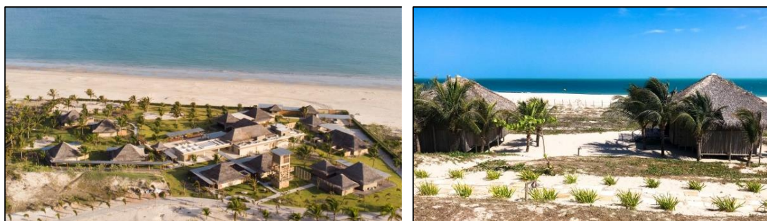
Figura 61– Praia do Preá, Trecho 2 da Unidade de Planejamento, Pousadas.
