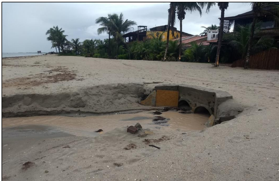
Figura 51 – Sistema de drenagem utilizado para compensar sistemas naturais interrompidos com a ocupação urbana.
