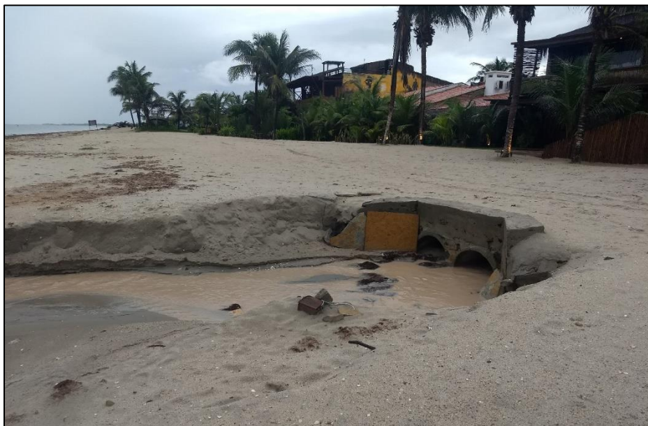
Figura 25: Sistema de drenagem utilizado para compensar sistemas naturais interrompidos com a ocupação urbana.
