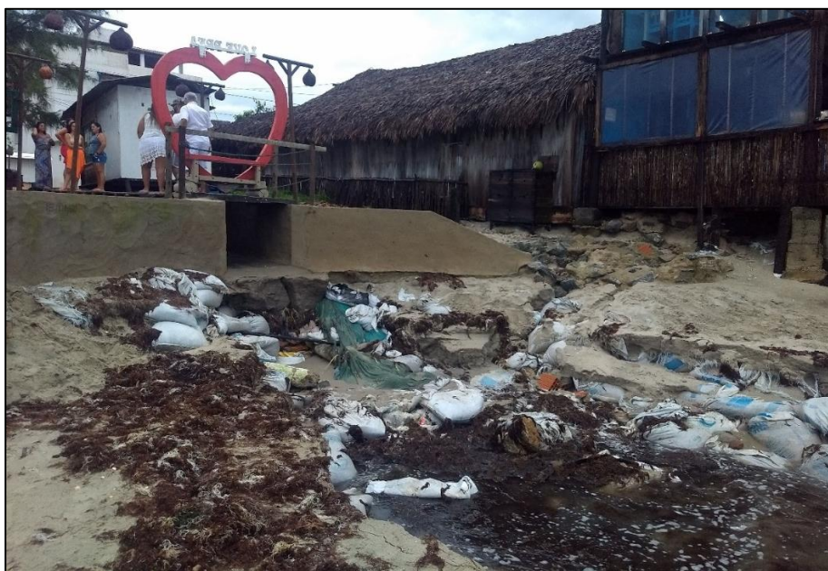
Figura 29: Barracas na faixa de praia, provocando mudanças nos padrões morfodinâmicos e hidrodinâmicos locais.
